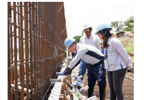
フェーズ4の工事の一環で、洪水壁を建設。日本の建設会社が安全かつ質の高い施工技術を共有。
