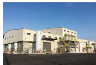
北九州アッシュリサイクルシステムズ株式会社 KitakyushuAsh Recycle Systems Co., Ltd(KARC)
