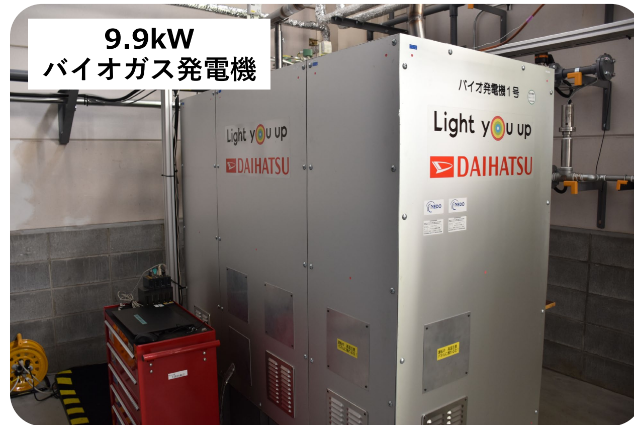
ガス濃度のばらつきに自動対応し、 安定的に発電可能な発電機
