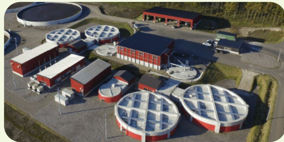
湿式プラント(瓜幕バイオガスプラント)
