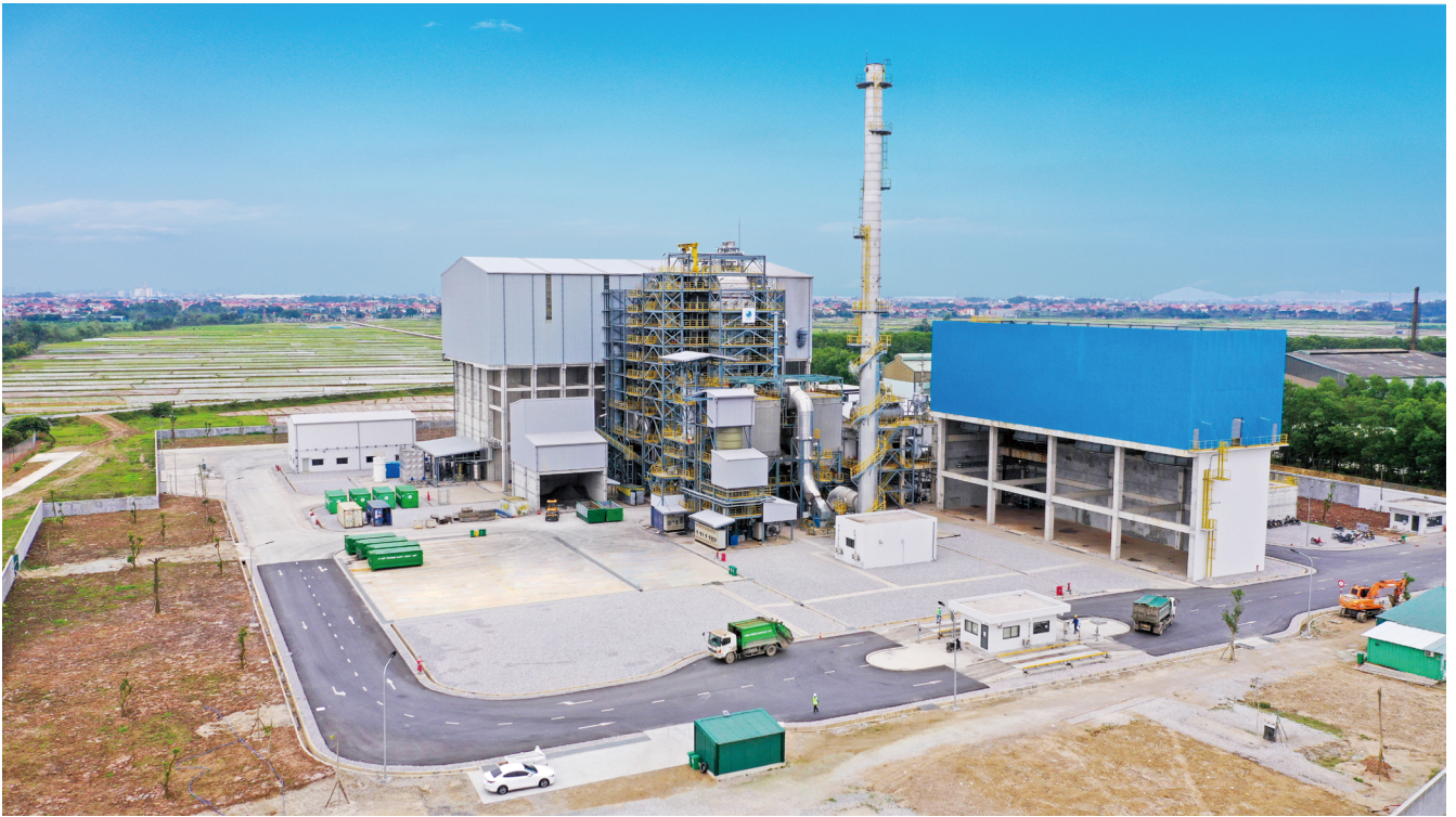
ベトナムバクニン省廃棄物発電施設完成全景
